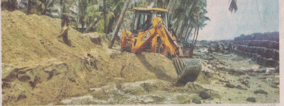
കടൽത്തീരമാലകളെ പ്രതിരോധിക്കാൻ ചെല്ലാനം പ്രദേശത്ത് മണൽവാടയുടെ നിർമ്മാണ പ്രവർത്തനങ്ങൾ ആരംഭിച്ചു ചോൾ.
